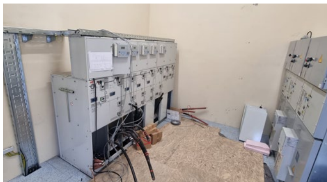
Slika 1: Montaža sredjenapetostne opreme transformatorske postaje
