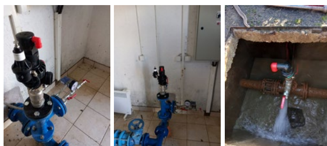
Slika 10-12: Pravilna namestitve novih zračnikov A.R.I.
