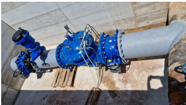
Slika 1-3: Postavitev ventila Bermad 718 na lokaciji naročnika
